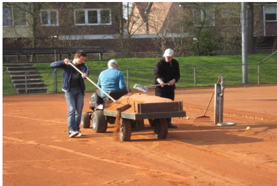
Afbeelding: gravel opbrengen
