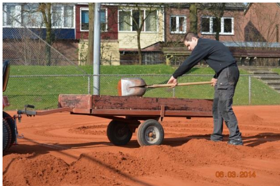
Afbeelding: aanhangwagen voor afvoeren vervuilde gravel
